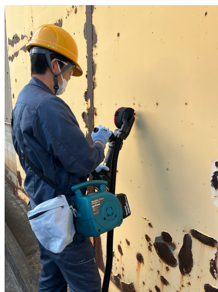
BBWコードレス+集塵カバー+集塵機 コードレスで動作しやすいです。
